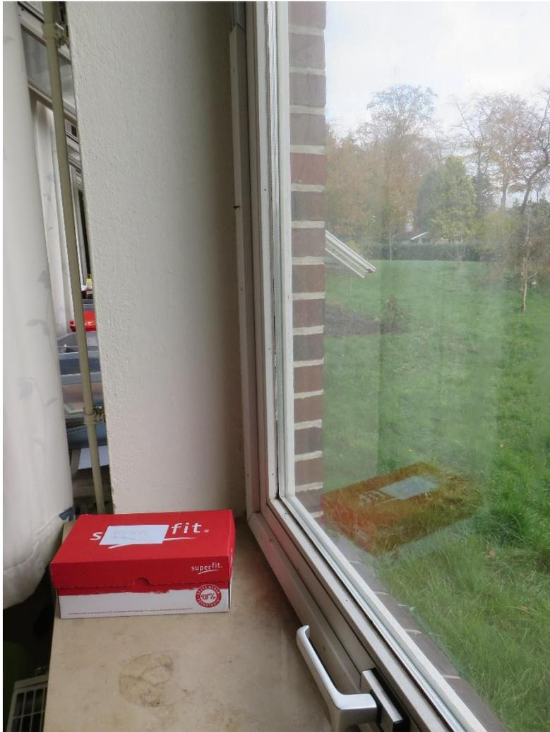
Bild 25 Holzfenster Baujahr 1988, teilweise keine Dichtungen
