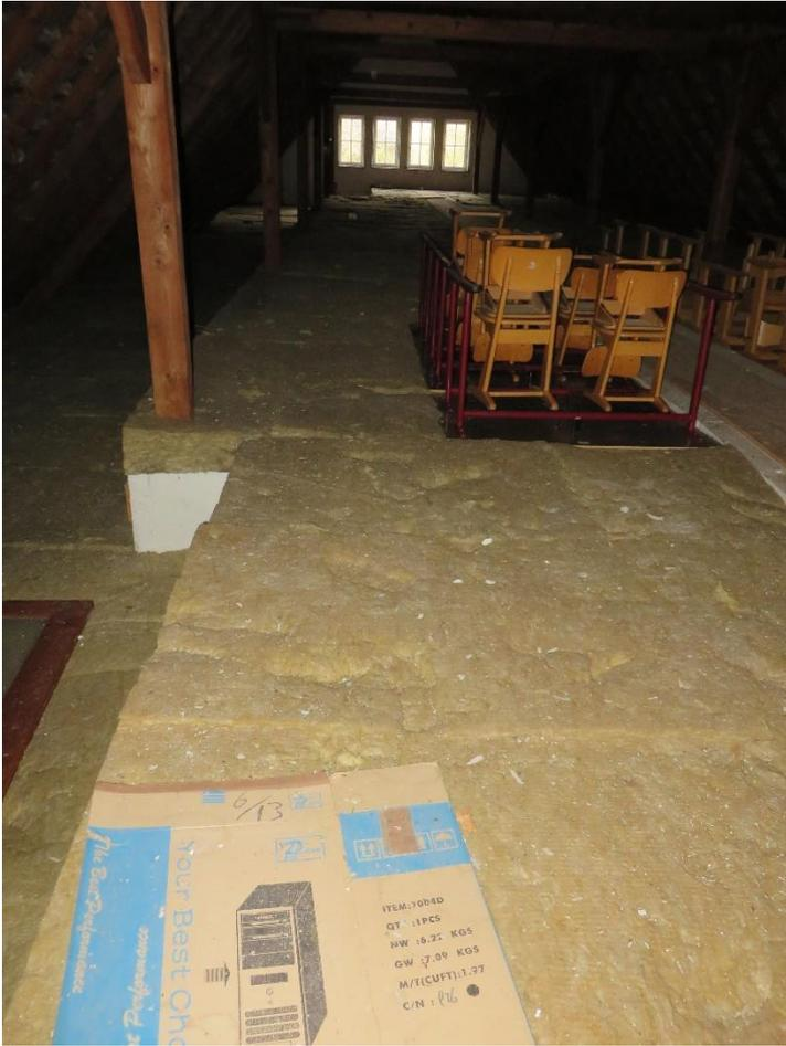
Bild 28 Dämmung oberste Geschosdecke
