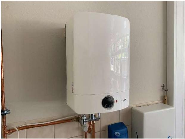
Bild 18 Warmwasser elektrisch
