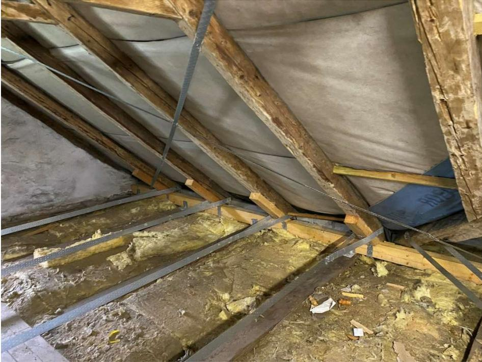
Bild 28 Dämmung oberste Geschosdecke
