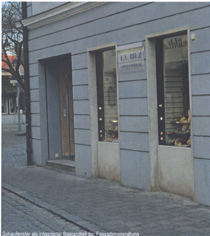
Schaufenster als integrierter Bestandteil der Fassadengestaltung
