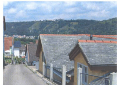
Flach geneigte Satteldächer mit Legschiefer
