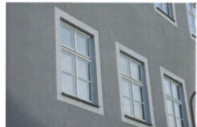
Historische Fensterteilung durch Sprossen
