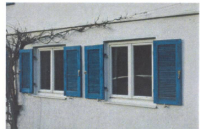
Klapppläden aus Holz als Schutzeinrichtung
