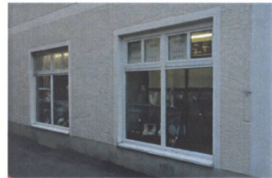
Schaufensterfläche, unterteilt mit Sprossen
