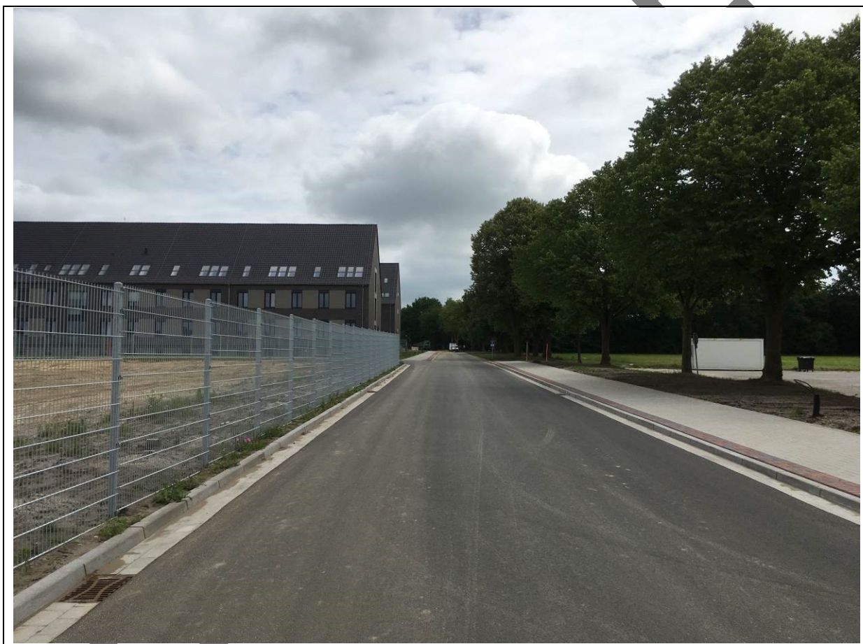
Abbildung 19: Blick in die fertiggestellte Sammelstraße
